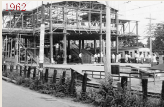
建築中の橋上駅舎。初代駅舎から西側へ移動した。前年にはホームを島式2面3線に変更している © 西東京市図書館
