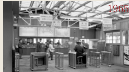
橋上駅舎後の改札内から切符売り場を見た様子 © 西武鉄道
